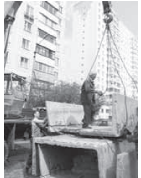
С улицы Пушкинской вывозятся бетонные плиты. По словам заместителя директора МУП «ЖКО» С.Н. Дюдака, по данным на 15.05.12 г., было вывезено 55 штук
