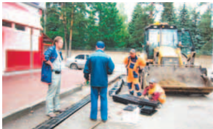
Подрядчиками ООО «Элайт» завершаются работы по благоустройству территории, прилегающей к торговому комплексу
