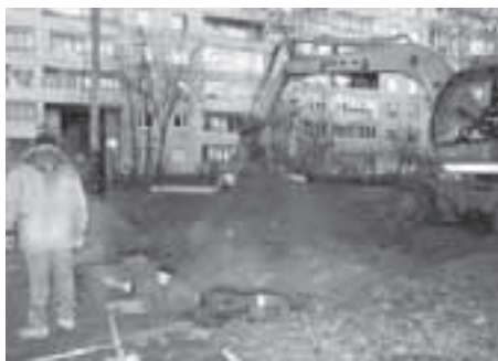
Бригада специалистов наружных тепловых сетей проводит работы по ликвидации порыва водовода горячего водоснабжения
