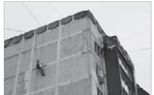
Работы по герметизации швов выполняются на доме № 16 по ул. Большой Комитетской
