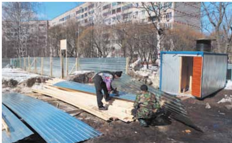
Работники подрядной организации выполняют работы по монтажу забора вокруг строительной площадки
