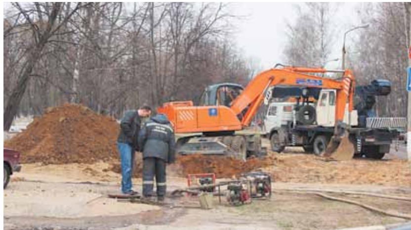
Работники МУП «ЖКО» в очередной раз ведут работы по устранению порыва трубопровода теплоснабжения в районе сквера третьего городка
