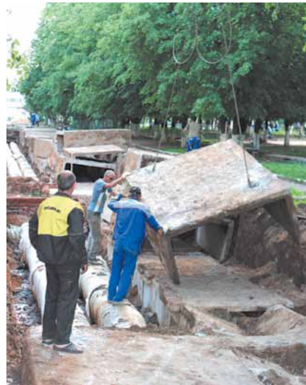
Замена трубопроводов на одном из наиболее аварийных участков города: в сквере 3-го микрорайона
