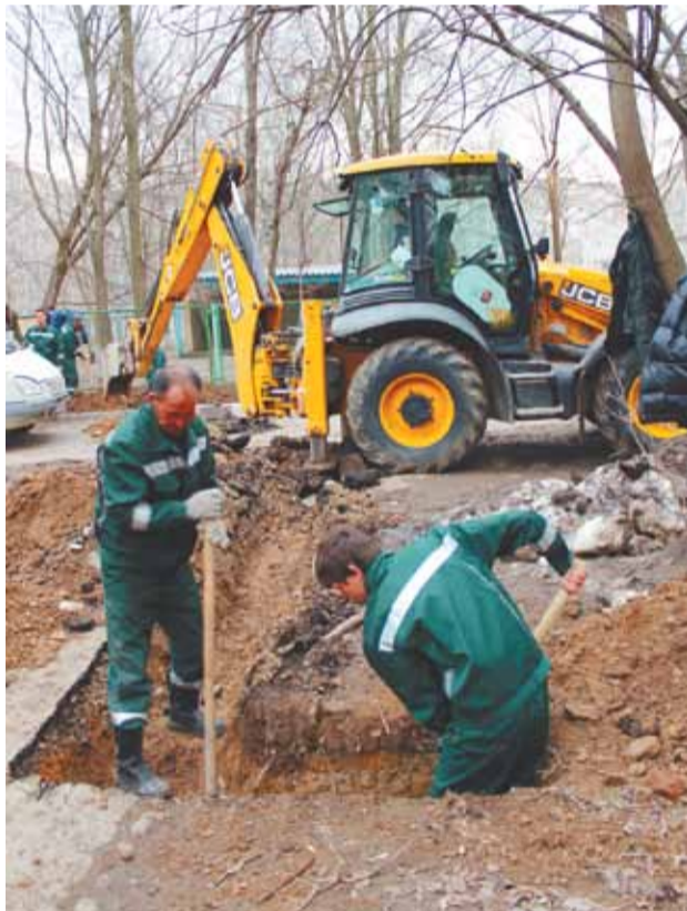
Выполняются работы по выносу высоковольтного кабеля за территорию стройки
