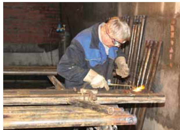
Выполняется сварка конструкций системы отопления цокольного этажа
